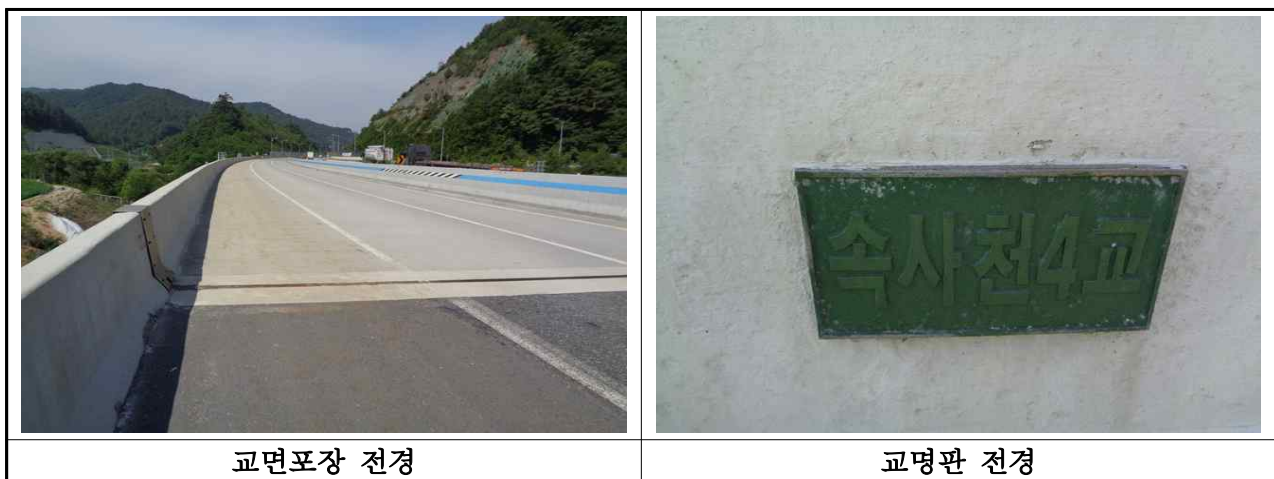
【사진 3.46】 교면포장 전경
