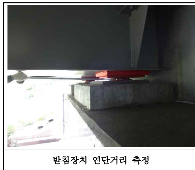
【사진 3.15】 교량받침장치 연단거리측정
