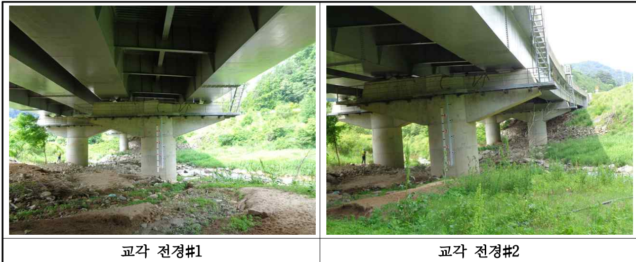
【사진 3.11】 교각 전경
