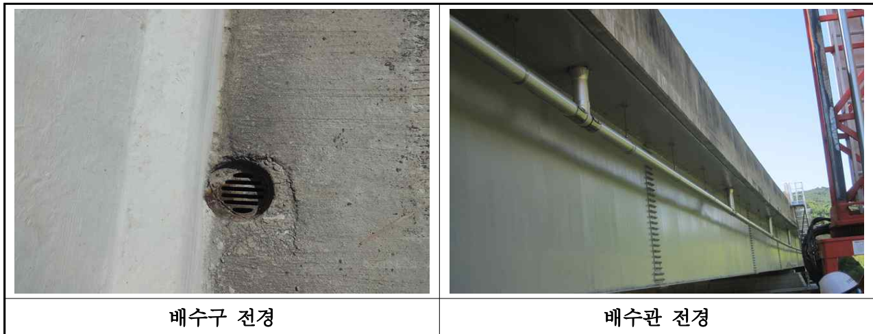
【사진 3.22】 배수시설 전경
