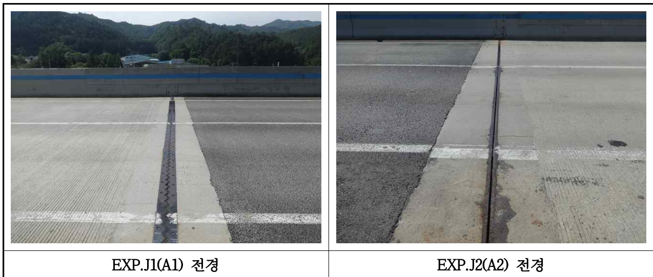
【사진 3.17】 신축이음장치 전경
