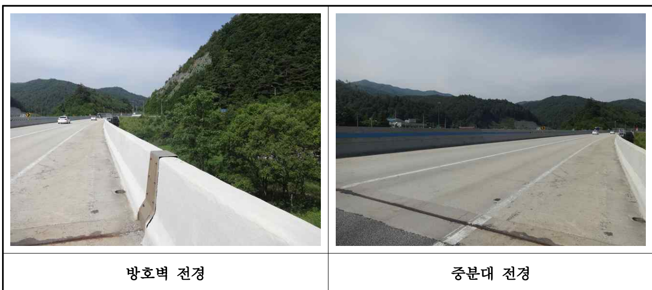
【사진 3.24】 방호벽 및 중앙분리대 전경
