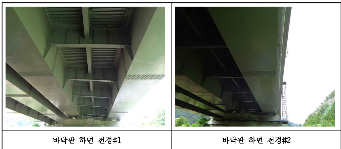
【사진 3.2】바닥판 전경
