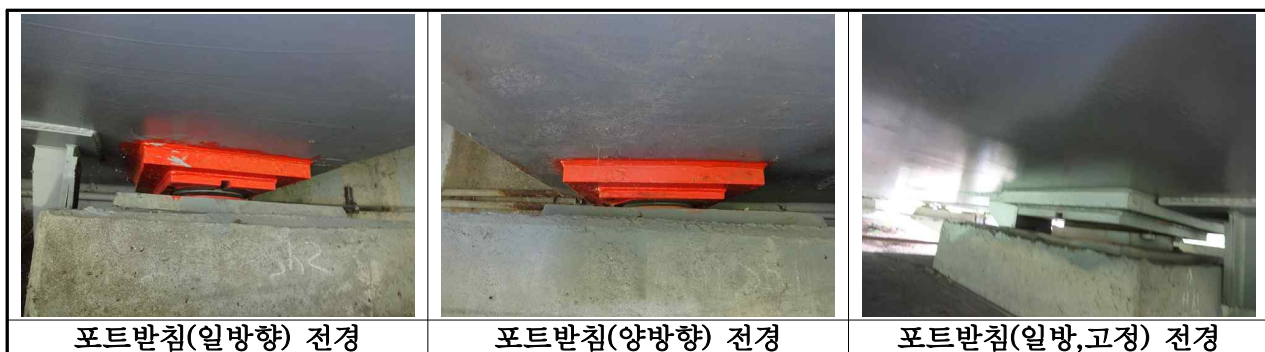
【사진 3.13】 교량받침 전경
