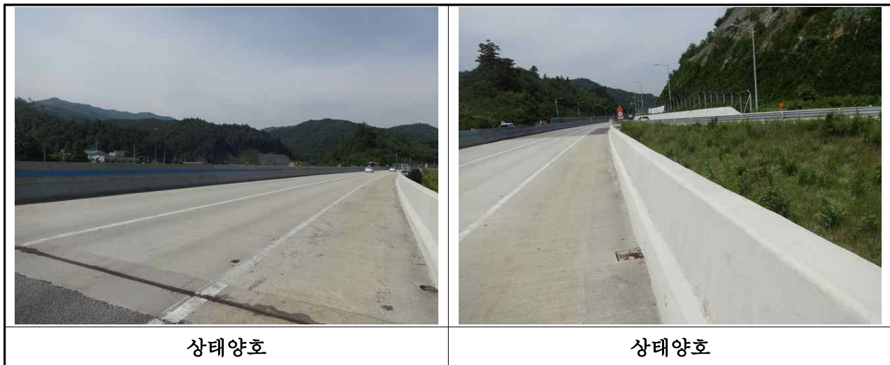
【사진 3.25】 방호벽 및 중앙분리대 손상현황
