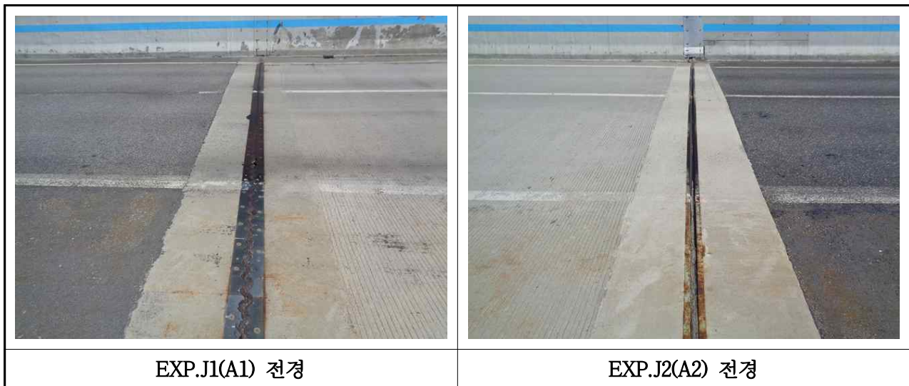
【사진 3.43】 신축이음장치 전경
