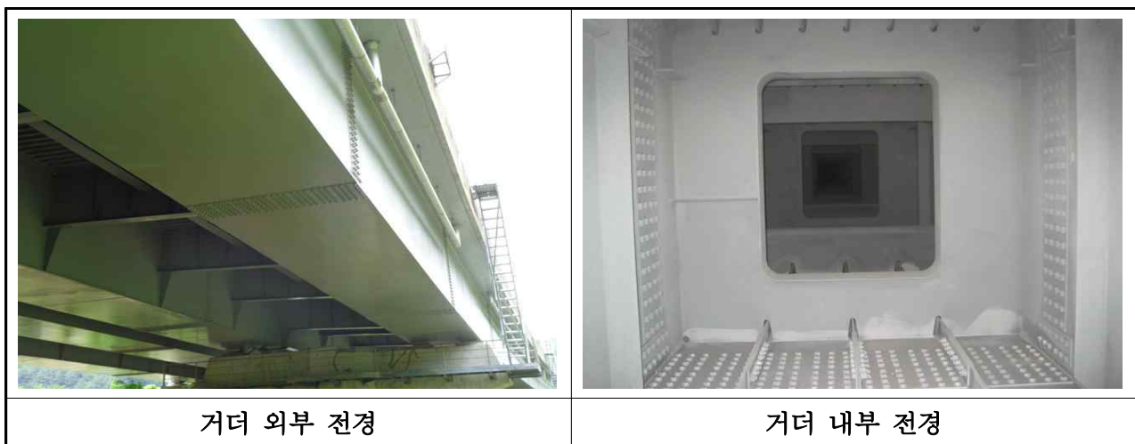
【사진 3.4】 거더 전경
