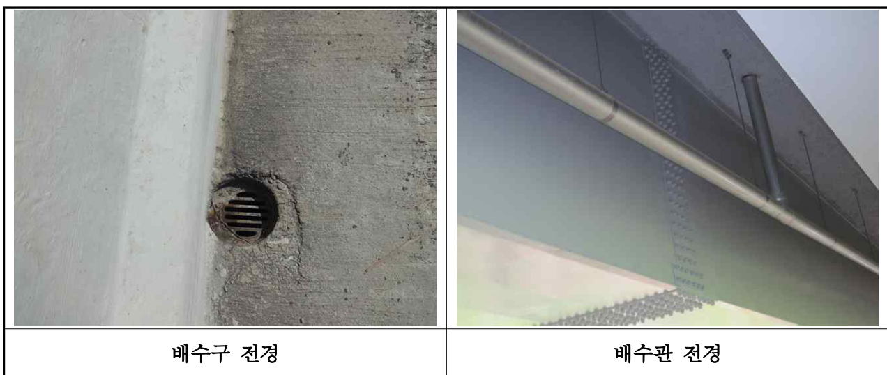
【사진 3.48】 배수시설 전경
