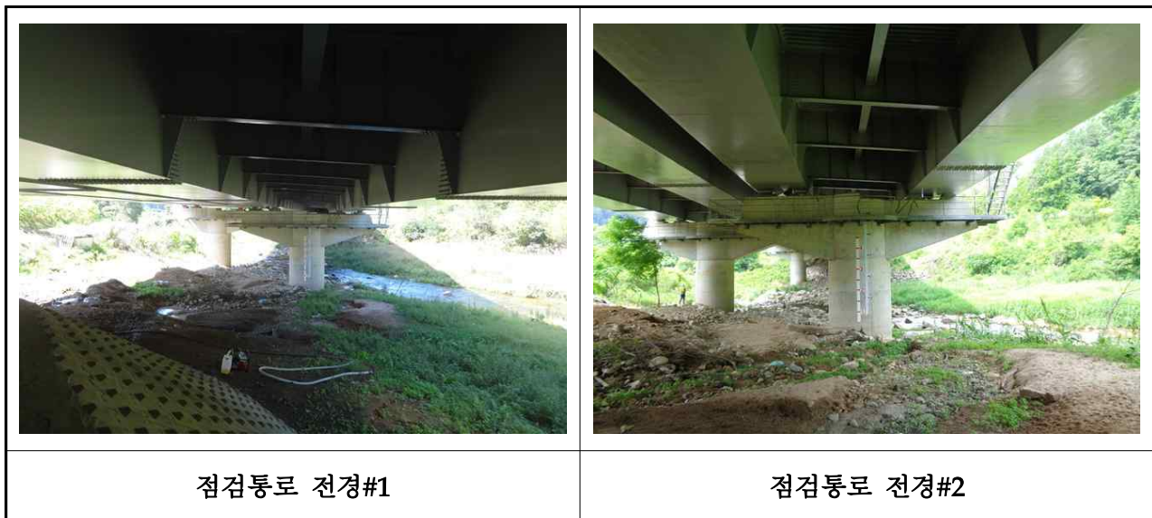
【사진 3.26】 교량 점검시설 전경
