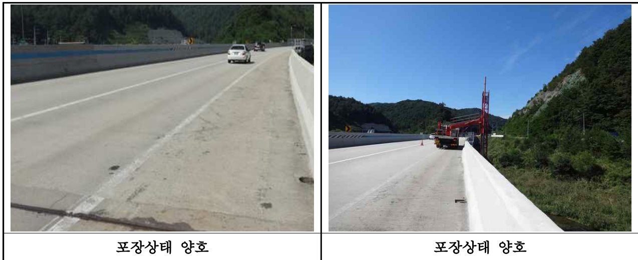
【사진 3.21】 교면포장 손상현황
