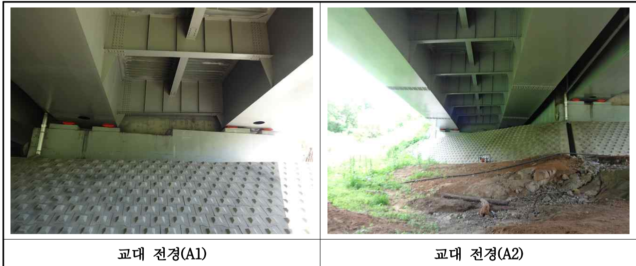
【사진 3.35】 교대 전경
