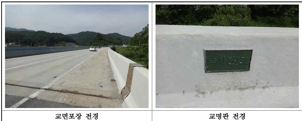
【사진 3.20】 교면포장 전경
