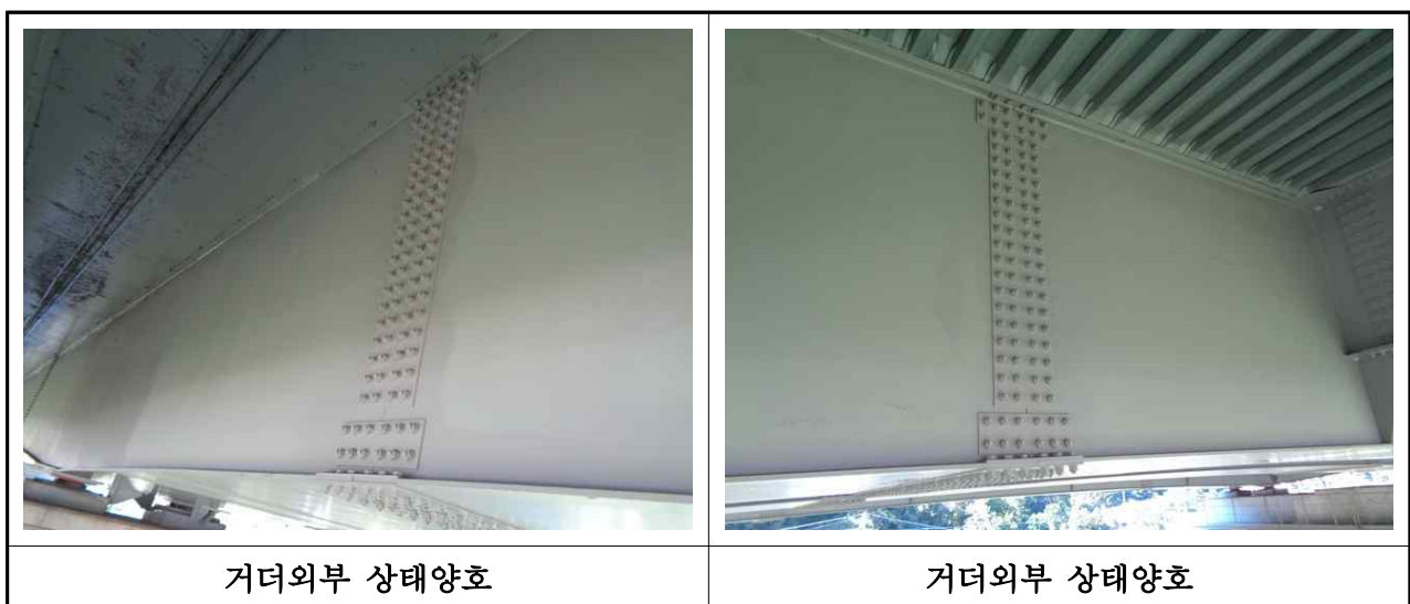
【사진 3.31】 거더 외부 손상현황
