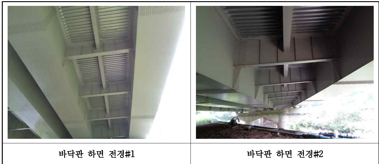
【사진 3.28】 바닥판 전경
