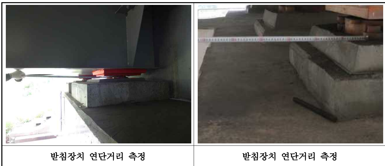
【사진 3.41】 교량받침장치 연단거리측정
