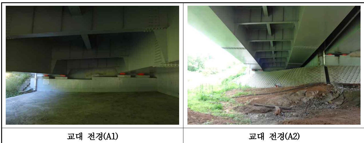
【사진 3.9】 교대 전경
