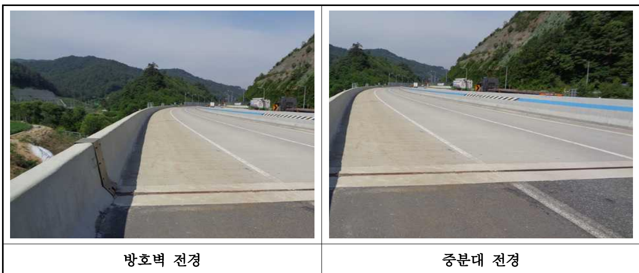
【사진 3.49】 방호벽 및 중앙분리대 전경
