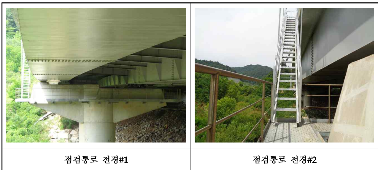
【사진 3.51】 교량 점검시설 전경
