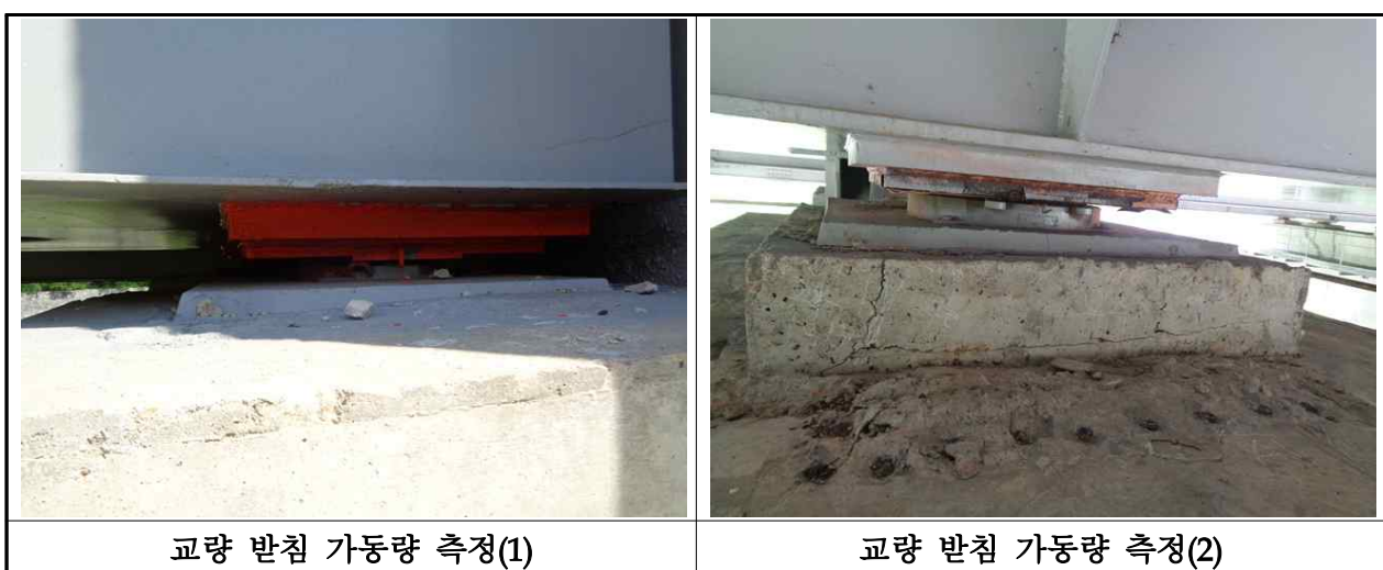
【사진 3.42】교량받침 이동량 측정
