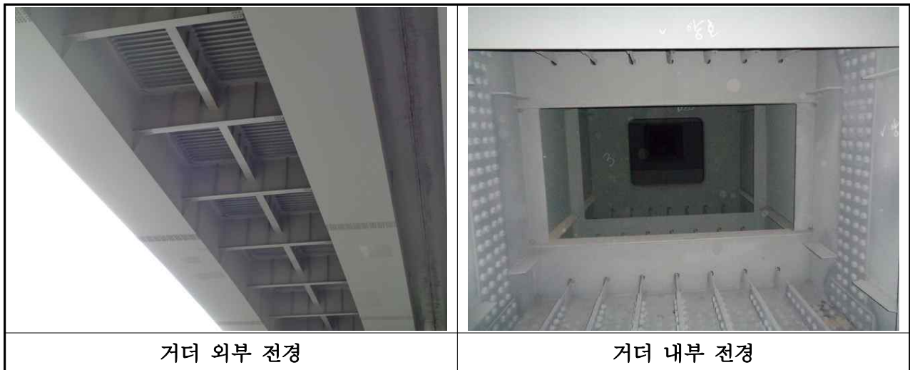
【사진 3.30】 거더 전경
