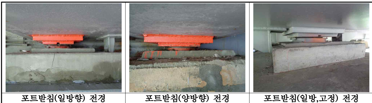
【사진 3.39】 교량받침 전경
