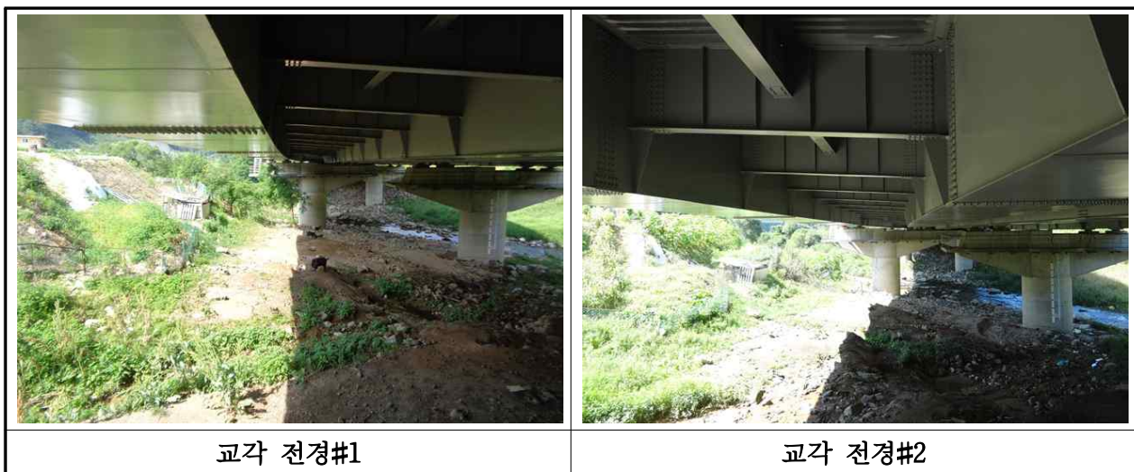
【사진 3.37】 교각 전경
